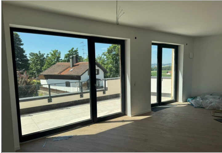
Wohnbereich mit Lüftungsanlage
