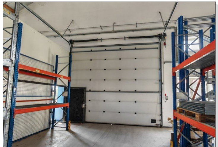
Lager- und Produktionshalle
