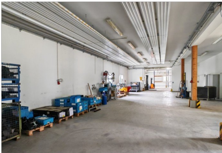
Lager- und Produktionshalle
