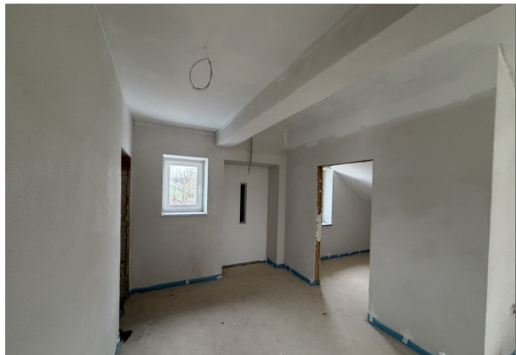
Eingang mit Lift
